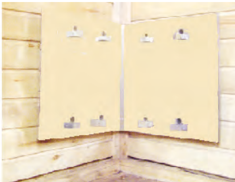
Фото 2. Установка термозащиты
